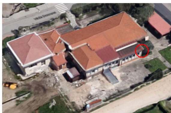
Fig.7 - Punto di installazione della VDS1
