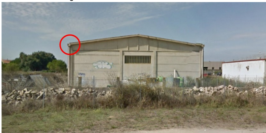
Fig.16 - Punto di installazione della VDS7
