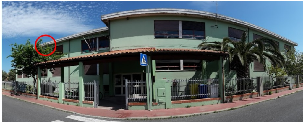
Fig.12 - Punto di installazione della VDS4
