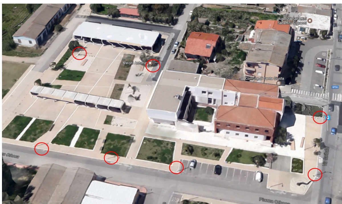
Fig.2 - Visione d'insieme dei punti di installazione dalle 9 telecamere presenti
