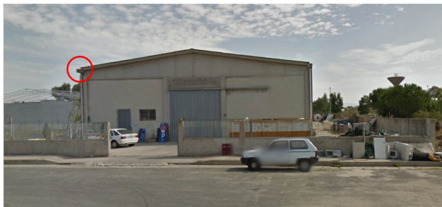
Fig.15 - Punto di installazione della VDS6
