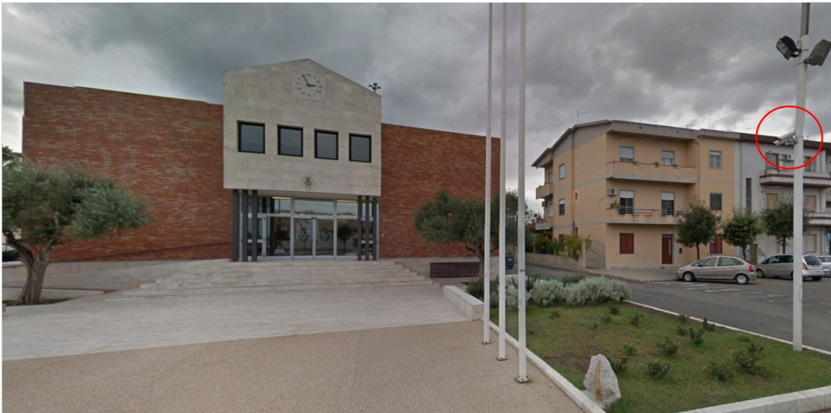
Fig.3 - Punti di installazione dettagliati dalle 10 telecamere presenti
