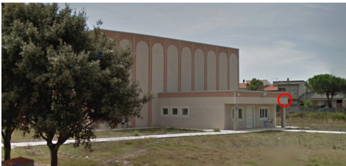
Fig.28 - Punto di installazione della VDS13
